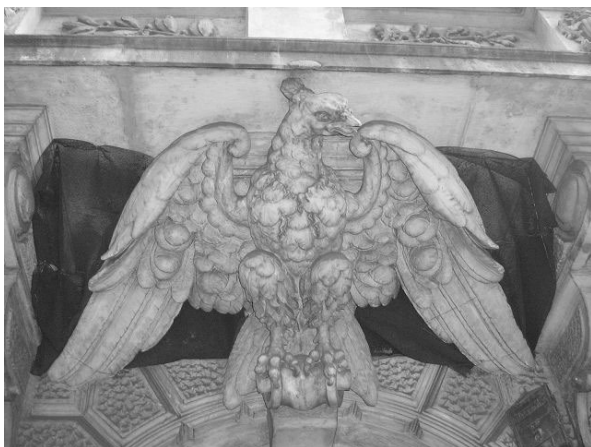
Ryc. 2. Ul. Długa 5, kamienica Trembeckich, proj. Maksymilian Nitsch, mur., 1889, wyk. Michał Korpal.
