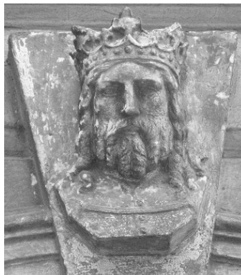
Ryc. 10. Ul. Długa 45, mur., 1892, proj. Leopold Tlachna. Rzeźba przedstawiająca Kazimierza Wielkiego.
