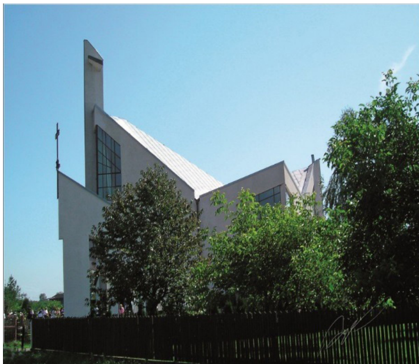
Fotografia 33. Widok boczny kościoła
