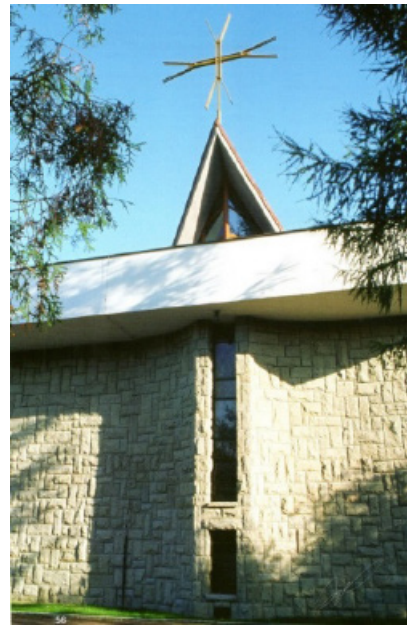
Fotografia 85. Elewacja kościoła od strony prezbiterium
