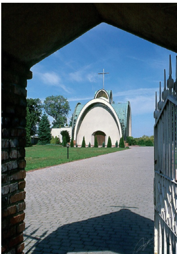
Fotografia 102. Widok na kaplicę z bramy wejściowej na cmentarz
