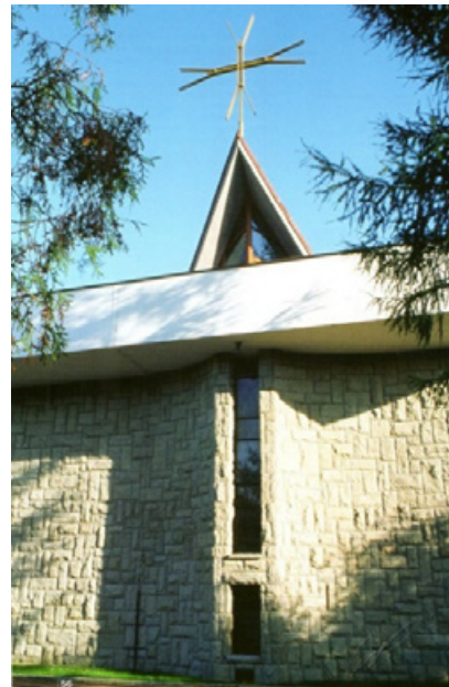
Fotografia 85. Elewacja kościoła od strony prezbiterium
