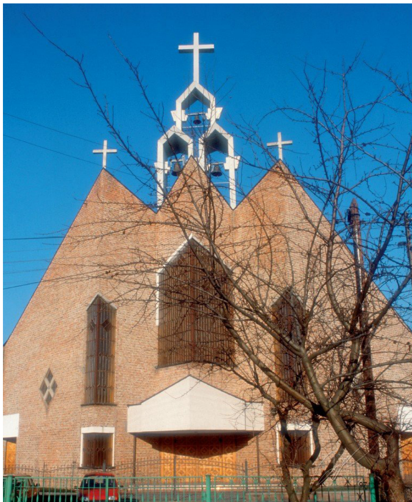
Fotografia 36. Kościół Rzymskokatolicki św. Stanisława Kostki w Zawierciu, widok fasady wejściowej kościoła
