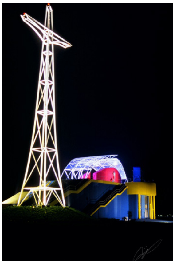
Fotografia 10. Krzyż nawiązujący konstrukcją do przedwojennej radiostacji w Gliwicach
