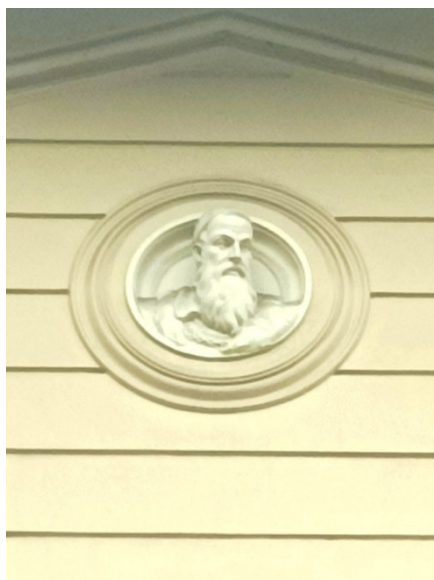
Fotografia 15. Willa „Zofijówka” – detale architektoniczne (źródło: fot. własna)
