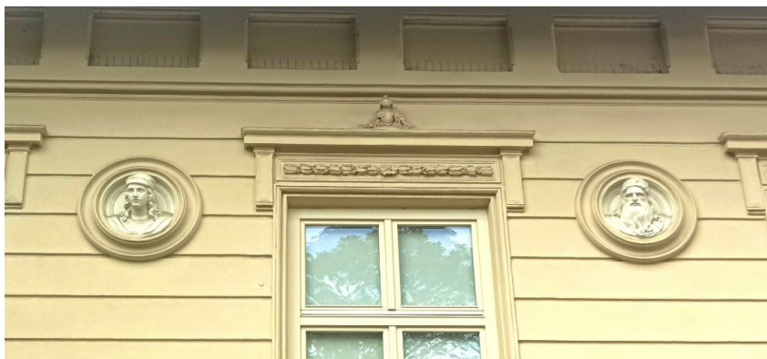
Fotografia 16. Willa „Zofijówka” – detale architektoniczne (źródło: fot. własna)
