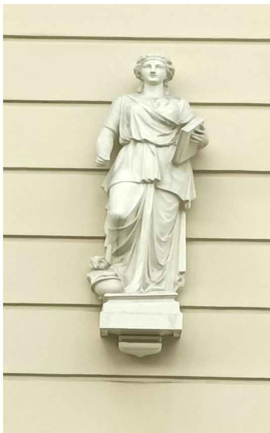
Fotografia 14. Willa „Zofijówka” – detale architektoniczne (źródło: fot. własna)
